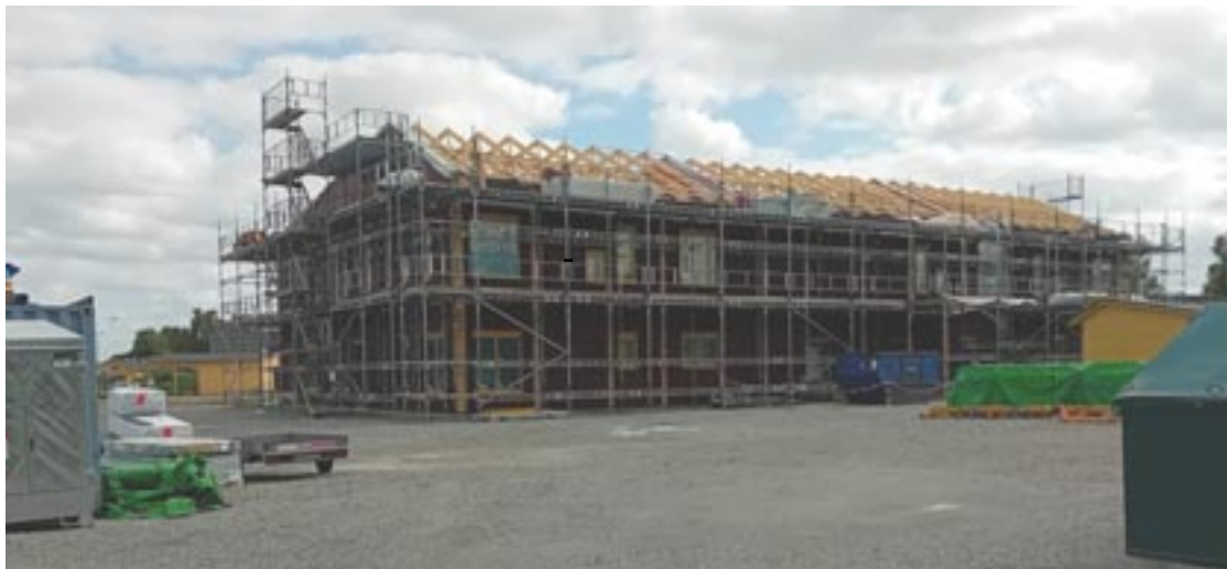
Grimslövs nya förskola börjar ta form och beräknas stå färdig 2026 för 120 barn fördelade på 6 avdelningar.
